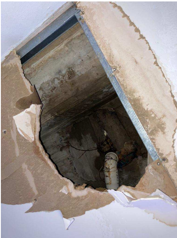
Foto 3: Pérdida de aguas servidas por cañería colgada del entrepiso, rotura del cielorraso.
