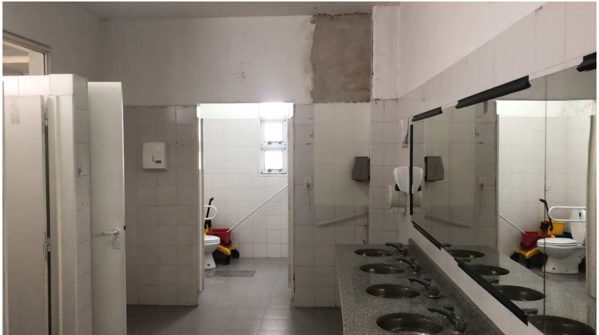
Estado actual: Baño damas planta baja.
