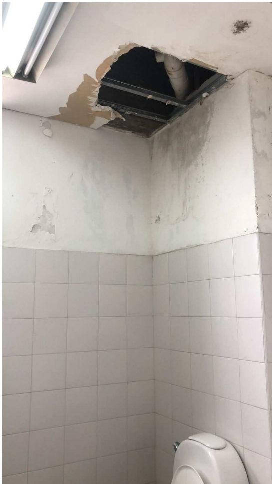
Foto 8 y 9: Baño de discapacitados, rotura s/ cielorraso por pérdida de aguas servidas.
