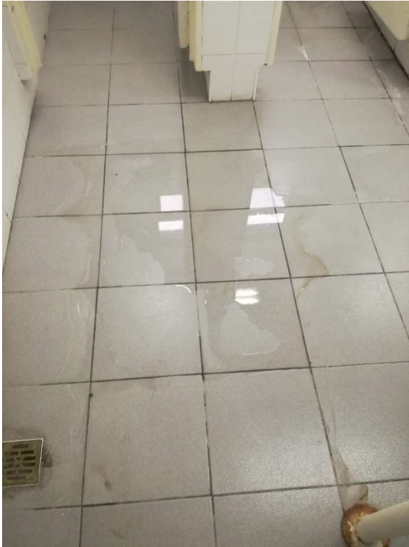
Foto 1: Presencia de agua por pérdida de cañerías de agua sanitaria.
