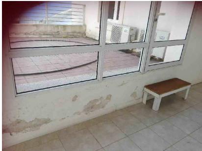
Foto 3 Y 4 -GRIETA A LO LARGO DE TODO EL PERÍMETRO DE LA TERRAZA S/ MUROS
