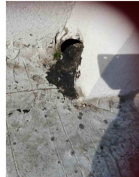
Foto 5 - DESAGÜE DE LOSA 2 S/ LOSA 4 CLL F°F° Ø110
