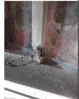
Foto 6 : LOSA DE VIGUETAS IN SITU CON HIERROS EXPUESTOS Foto 7 : COLUMNA CON HIERROS EXPUESTOS
