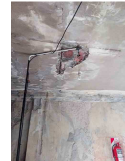
Foto 6 : LOSA DE VIGUETAS IN SITU CON HIERROS EXPUESTOS Foto 7 : COLUMNA CON HIERROS EXPUESTOS
