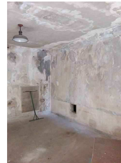
Foto 4 y 5 - REVOQUE INTERIOR SUELTO
