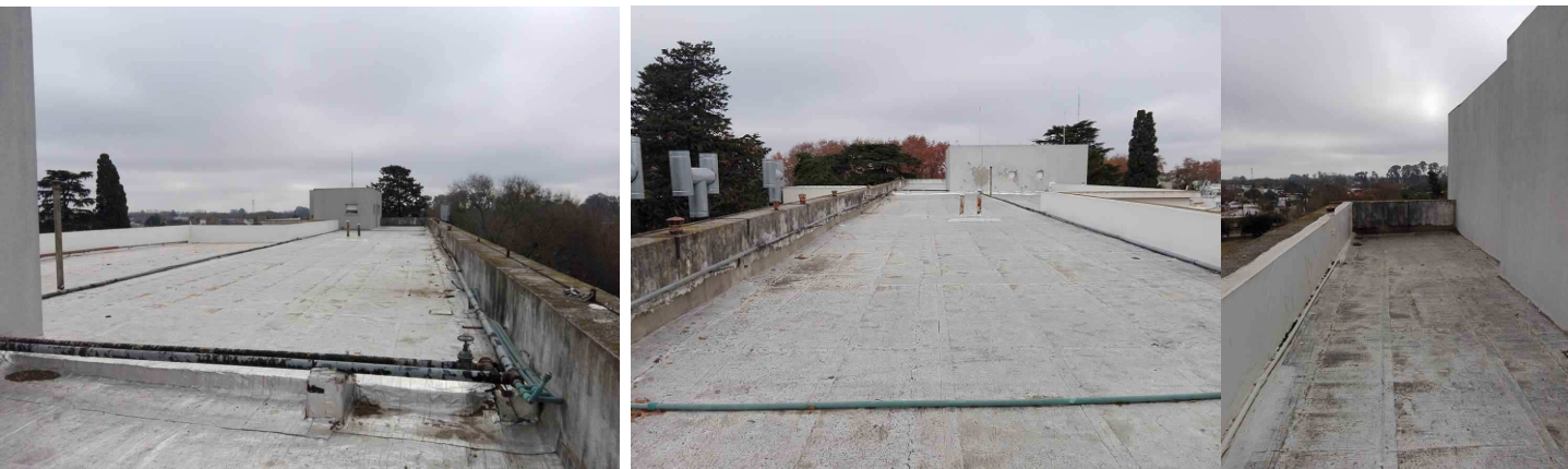
LOSA 4 Foto 1 Y 2 - LOSA 4 VISTA HACIA SALA DE MÁQ. 2 Y SALA DE MÁQ. 1 RESPECTIVAMENTE, CAÑOS DE AGUA S/ LOSA, CONDUCTOS DE EXTRACCIÓN, Y AGLOBIAMIENTO DE MEMBRANA ASFÁLTICA
