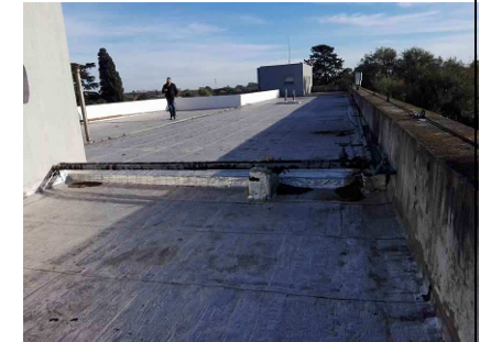
Foto 4 - MURO DE CARGA LIMITE E/ LOSA 3 Y LOSA 4
