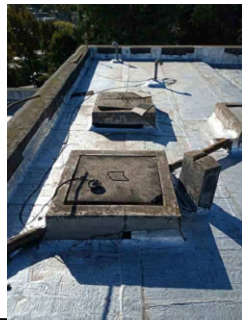
Foto 7 y 8 - LOSA 1 / CUBIERTA SALA DE MÁQUINAS, TAPAS DE REGISTRO TR Y SUPERPOSICIÓN DE PARCHES EN TODA LA SUPERFICIE CON MEMBRANA ASFÁLTICA
