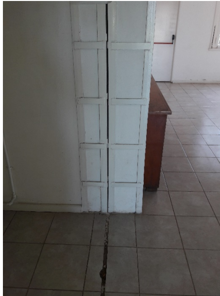
Figura 1. Junta de dilatación
