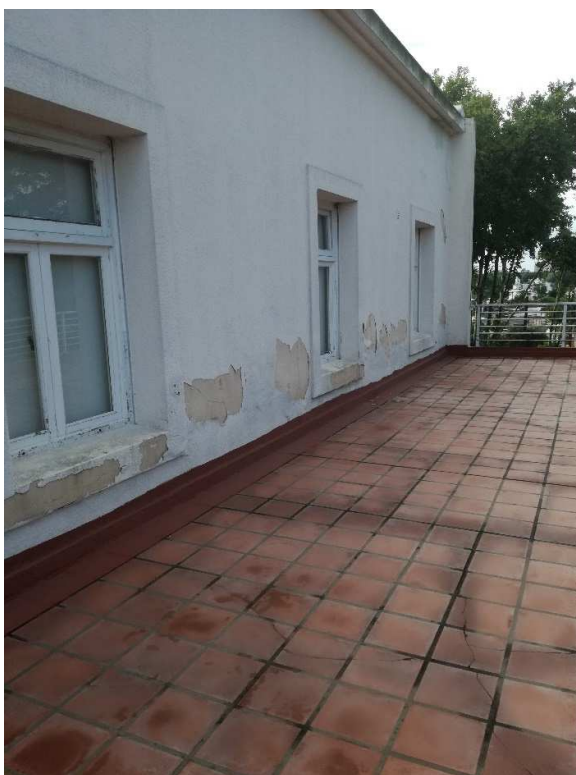
FOTO 9,10 y 11: Vista pasillo ala derecha, adyacente a la terraza, muro exterior e interior con humedad ascendente.
