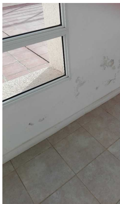
FOTO 9,10 y 11: Vista pasillo ala derecha, adyacente a la terraza, muro exterior e interior con humedad ascendente.
