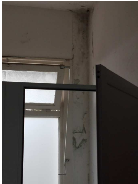
FOTO 3 y 4: Baño, filtración sobre pared donde se encuentra la bajada pluvial
