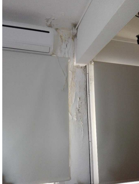
FOTO 1 y 2: Aula, filtración sobre pared donde se encuentra la bajada pluvial
